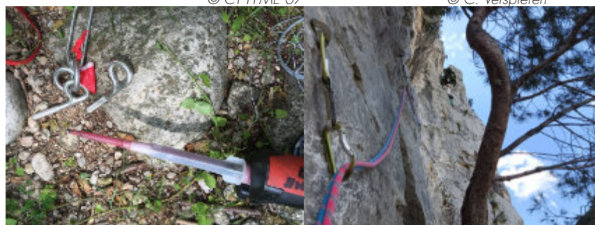
Matériel pour équiper avec des broches scellées (photo de gauche). ►
