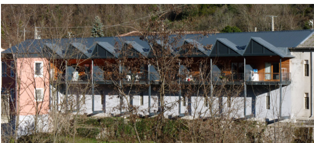
Moulinage réhabilité en logements à Burzet.
