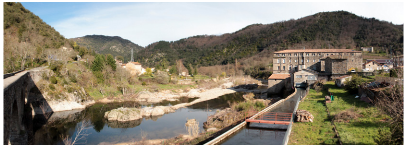
Etablissement de moulinage réhabilité au Moulinon.
