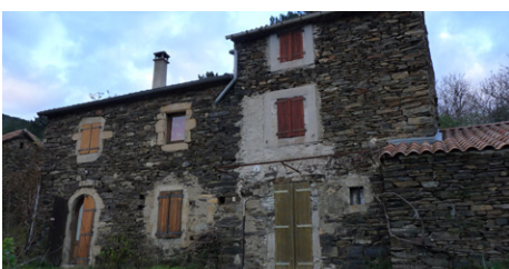
Constructions en Schiste à Saint-Mélany.
