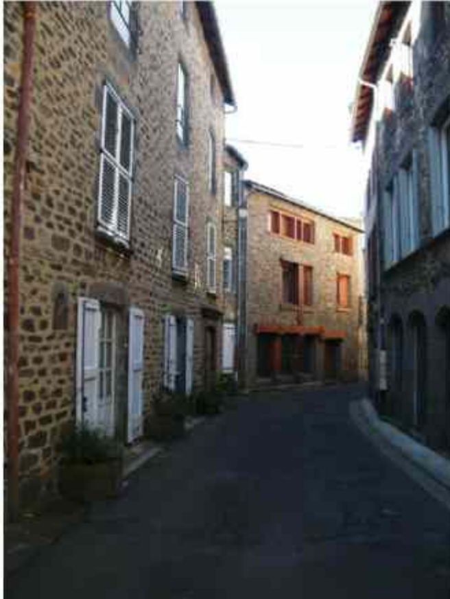
Des façades résidentielles ravalées
