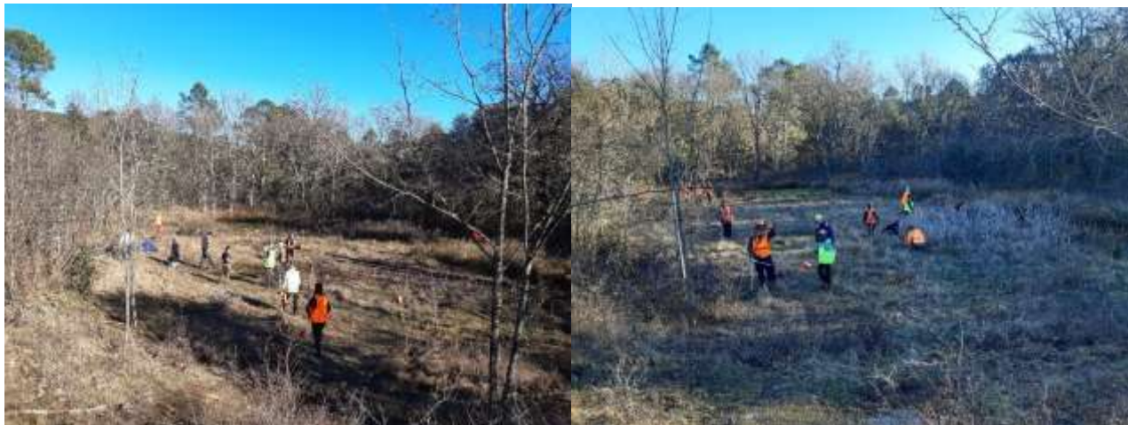
Chantier mare d'Abeau BTS GPN
