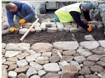
Mise à niveau d'une pierre sous la pige posée sur deux conducteurs. PNR des Monts d'Ardèche, Chantier école ELIPS, Genestelle.
