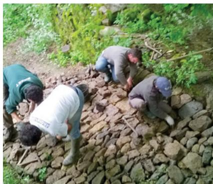
Finition d'une calade en lit de ruisseau, stage thématique ELIPS ouvrages hydraulique, chambre d'agriculture d'Ardèche, château du Pin, Fabras.
