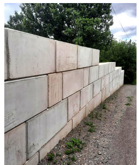
Mur en blocs béton préfabriqués
