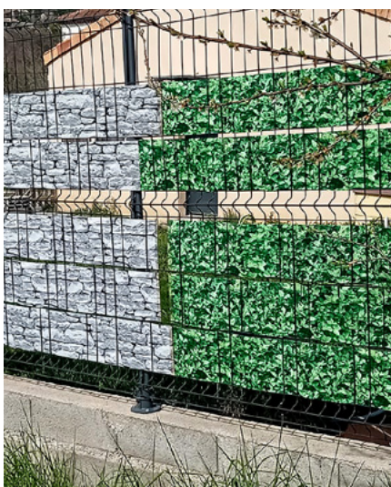
Grillage et plastique imprimé sur soubassement en parpaings non enduits
